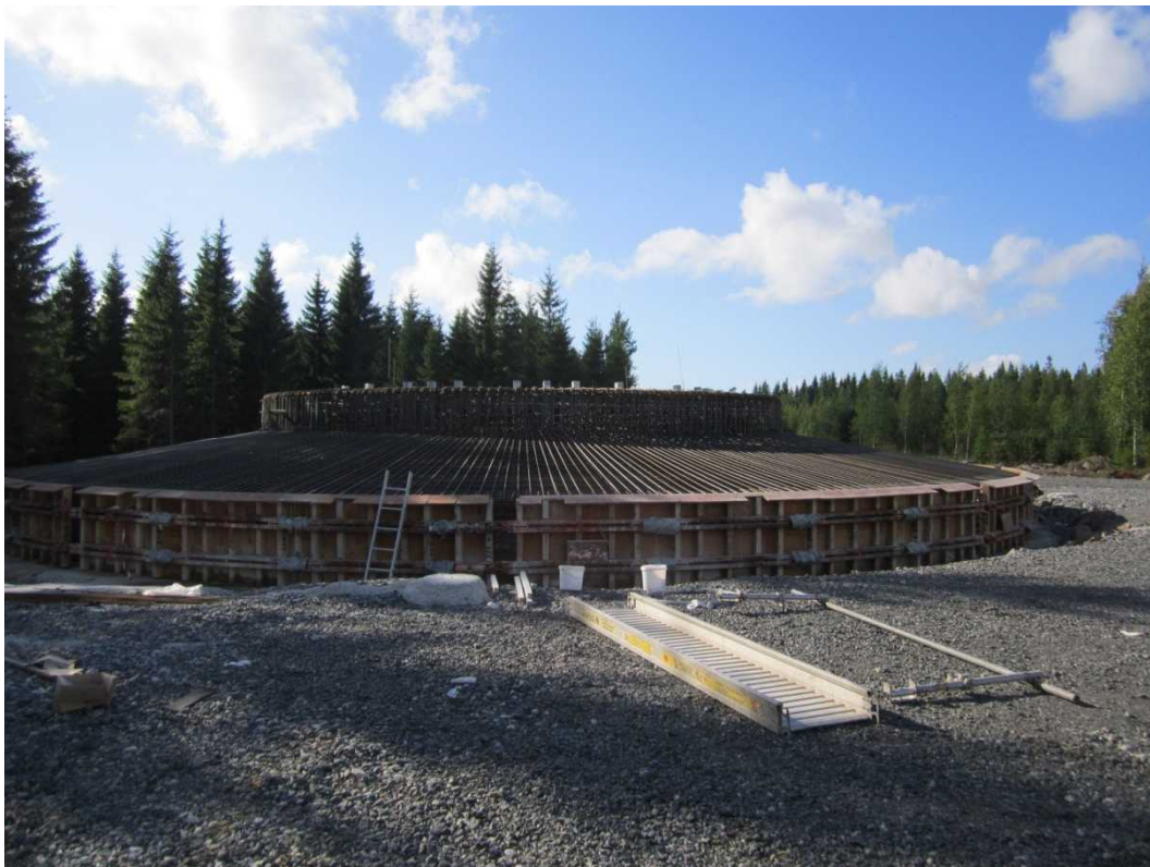
Kuva 7-4 Kuvassa esimerkki tuulivoimalan perustusten rakentamisesta
