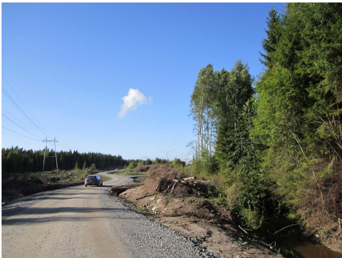
Kuva 7-5. Kuvassa tyypillinen tuulivoimaloille johtava huoltotie
